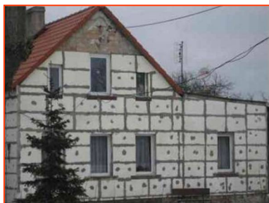
Fot. 6.2.11÷6.2.12 Przykłady nieprofesjonalnego wykonawstwa docieplenia
