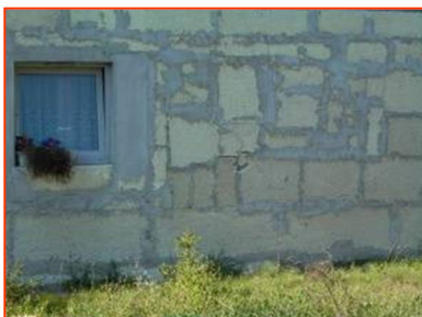
Fot. 6.2.11÷6.2.12 Przykłady nieprofesjonalnego wykonawstwa docieplenia
