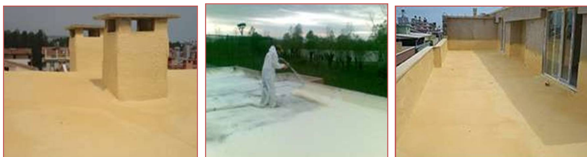
Fot. 6.2.2÷6.2.4 Metoda natryskowa docieplenia stropodachów pełnych
