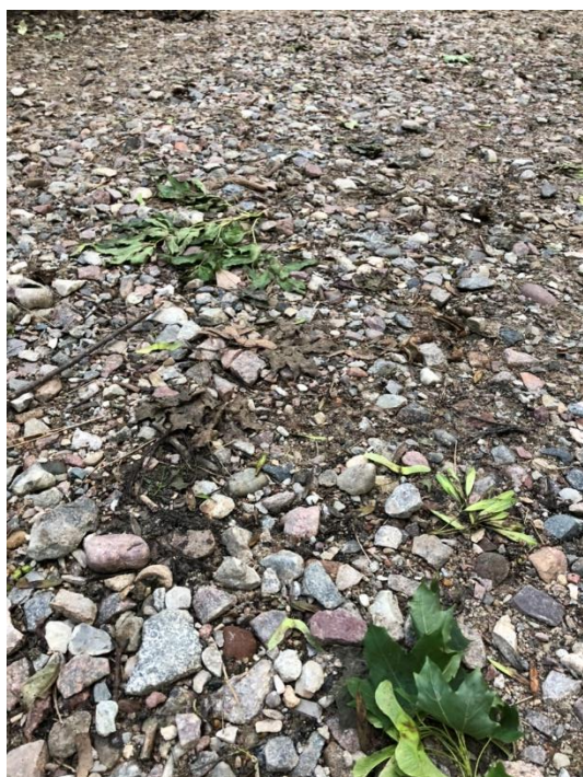
Zdjęcia 2,3. Przykładowe fragmenty ścieżek bez właściwego utwardzenia i struktury
